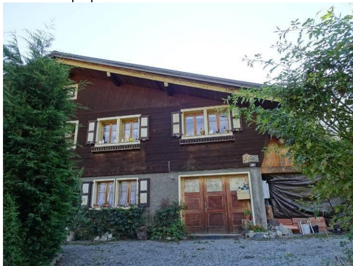
Réhabilitation années 60. Ouvertures régulières, agrandies murs maçonnés remontés. Les Houches, rte Chavants-195_p3637
