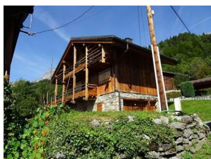
Les galeries transformées en grands balcons
