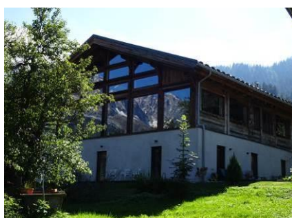
Les parties granges trop vitrées
