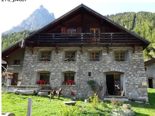
Augmentation du nombre d'ouvertures, régularité dans la composition, balcon dans les combles. Vallorcine, Les Regards, rte Biolles-37_p1358
