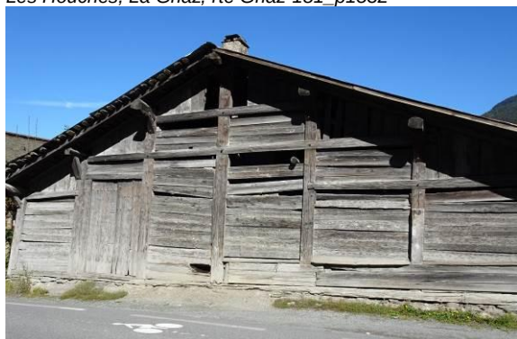
Fermeture de la grange, système à plateaux, porte de grange Les Houches, L'Essert, r Essert-398_p987
