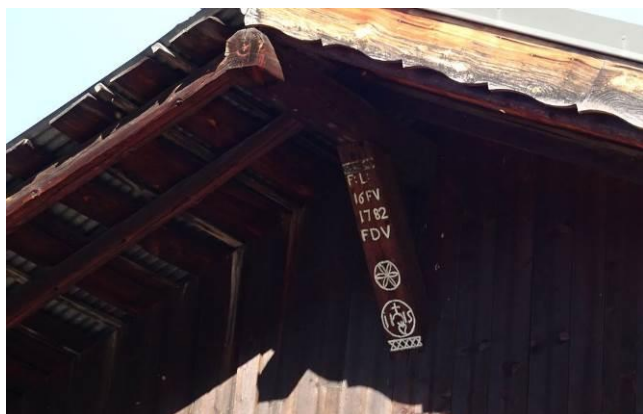
Contrefiche (« éparon ») portant une inscription : date de construction, initiales du propriétaire, motif symboliques et religieux. Les Houches, rte du Lac-476_p78-79_
