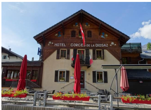
Servoz, Hôtel des gorges de la Diosaz, Le Bouchet, rte Mont-81, Extension latérale, rénovation de la façade dans le style chalet (bardage bois en pignon), simplification du décor d'origine, modification des ouvertures du comble.
