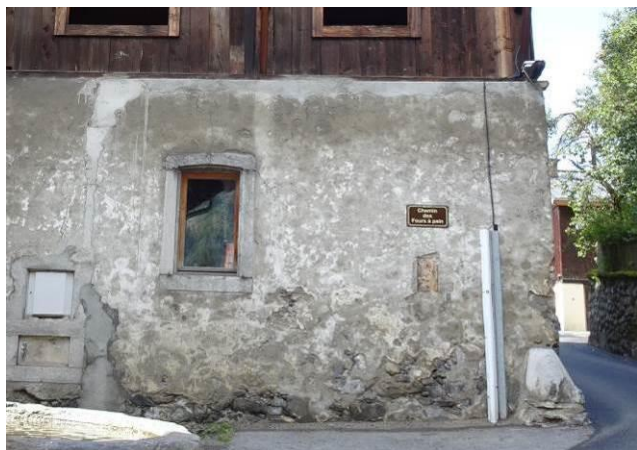
Servoz, reste d'enduit sur un mur en pierre. Tous les murs en pierre étaient enduits. En règle générale l'enduit était jeté sur les pierres et raclé à la truelle. Tout aspect de pierre apparente correspond à un enduit usé.
