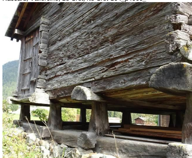
Raccard à Vallorcine, Le Crot, rte Crot-104_p4060_détail du système de support
