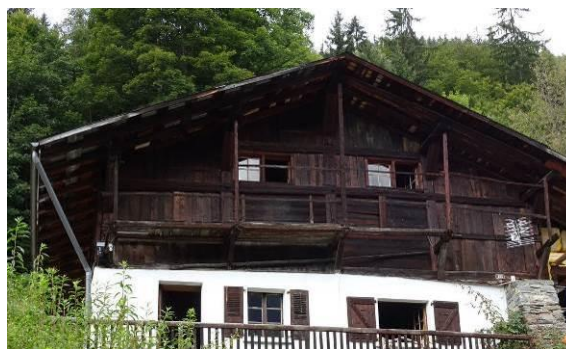
Galerie. Les Houches, Vaudagne, ch Ravanets-405_p1348.
