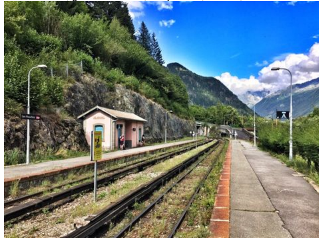
Les Houches, gare des Houches, abri, Coupeau, rte Gare-440
