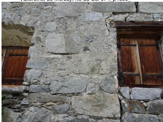
Détail d'un mur en pierre, date gravée, 1810 Vallorcine, Le Crot, Voie C3-135_p3956
