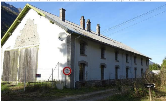
Vallorcine, Gare Plan de l'Envers, bâtiment de service
