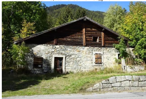
Espace ouvert, sans clôture. Fontaine-bassin. Vallorcine, Le Morzay, rte du Col-974_p4699
