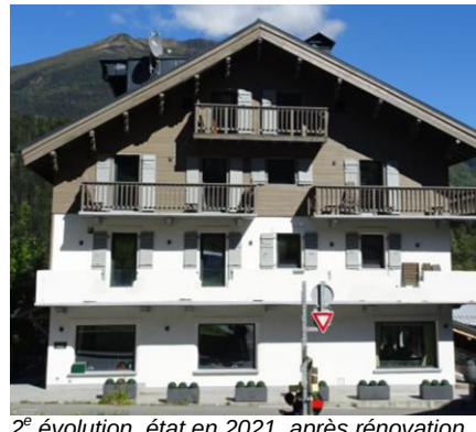
2 e évolution, état en 2021, après rénovation
