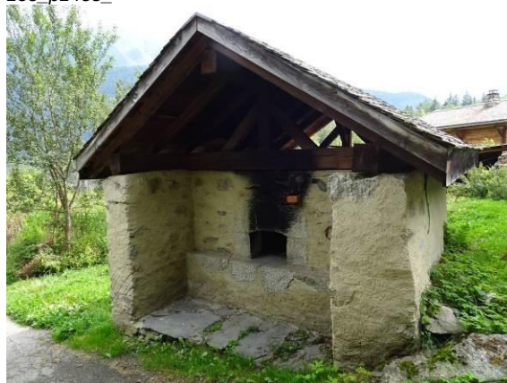
Four à pain, les Houches, Vaudagne, ch Vieux Four-44_p4531_
