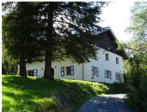
Réhabilitation années 60. Ouvertures régulières, murs maçonnés remontés. Les Houches, rte Granges-576_p1295_
