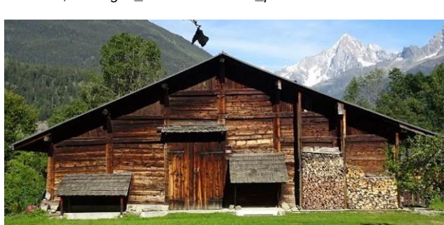
Système de fermeture à plateaux rénové, porte de grange conservée. Les Houches, Les Crêts_rte Aillouds-103_p3801
