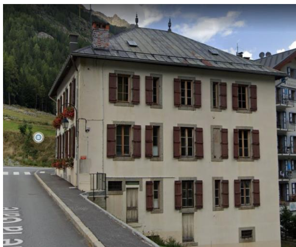
Vallorcine, mairie, arrière
