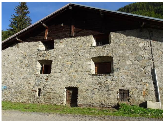
Fenêtres avec un ébrasement extérieur surmontées d'une voussure. Vallorcine, Plan-Envers, rte Forêt Verte-102_p3479
