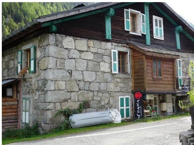
Augmentation du nombre d'ouvertures, ouvertures dans les combles, volets bicolores. Vallorcine, Le Sizeray, rte Eglise-276_p4687
