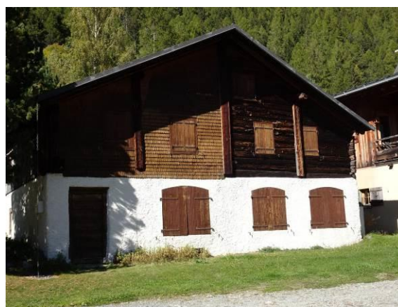
Pignon fermé par des plateaux. Une partie est recouverte de tavaillons. En angle les plateaux sont assemblés à mi-bois. Vallorcine, Chanté, chemin de Chanté-123_p1173
