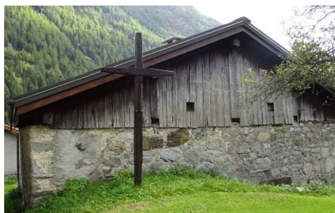
Pignon fermé par un mantelage, ouvertures d'aération. Vallorcine, Le Sizeray_rte Diligences_p1556_
