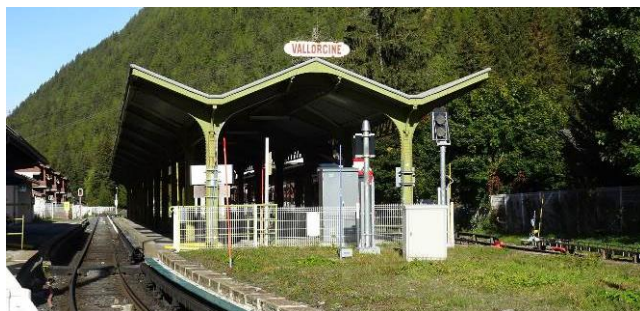
Vallorcine, Gare internationale, Plan de l'Envers, un auvent en structure métallique protège les voyageurs des intempéries.
