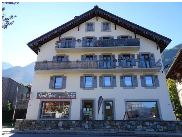
Les Houches, Chef-Lieu, pl Mairie-51_p2293 R-d-Ch transformé en commerce, rajout d'un balcon au 3 e étage, les menuiseries du 1 er étage n'ont plus de partition
