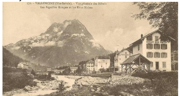
Perception de l'Eau Noire sur les cartes postales anciennes, qui montrent le torrent en lien direct avec ses abords enherbés et les bâtiments proches.
