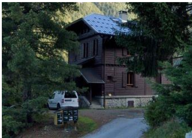
Les Houches, Taconnaz, rte Taconnaz-285. Villa construite en bois, dans le style chalet suisse.
