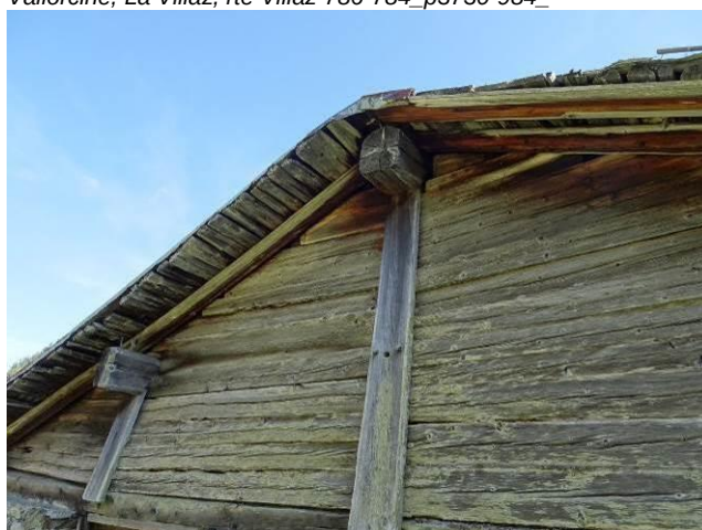
Système de fermeture à plateaux. Vallorcine, Le Mollard, ch Cascade-347_p786_
