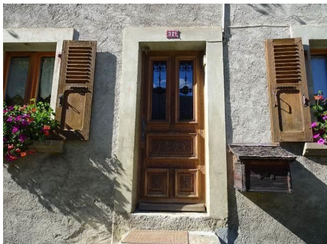
Porte d'entrée ouvragée, volets à cadres, persiennés en partie haute. Vallorcine, Barberine, rte Barberine-321_p128_
