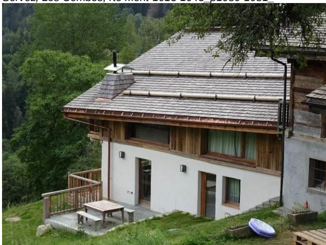
Rénovation récente. Les Houches, Bouchards, ch Mt Borrel-610_p1775
