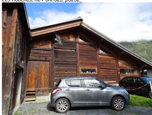
Grange aménagée en habitation. Les Houches, Griez_ch Rassettes_p4134-4594
