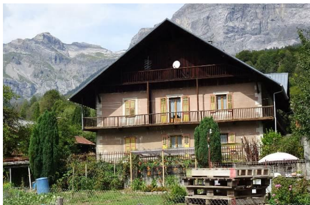
L'enduit pouvait aussi être traité plus finement et coloré avec décor peint pour les encadrements d'ouvertures et les chaînes d'angle. Vieux Servoz
