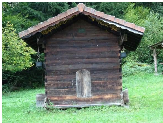
Grenier simple, Les Houches, plaine Saint Jean, rte de la Ferme_p2264
