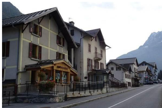
Vallorcine, Chef-lieu, rte Confins-146-140-132 Extensions en façade au niveau du rez-de-chaussée, suppression de balcons.
