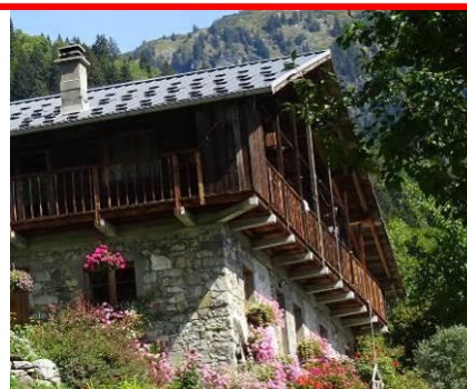
Les supports de balcons en béton
