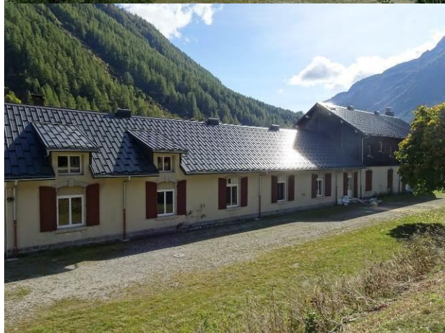
Vallorcine, Le Morzay, rte du Col-805 La sous-station électrique du PLM est devenue un centre de vacances SNCF
