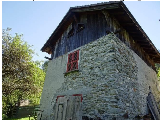
Détail d'un mur en pierre (l'enduit a été partiellement enlevé). Les Houches, L'Essert, r Essert-394_p987
