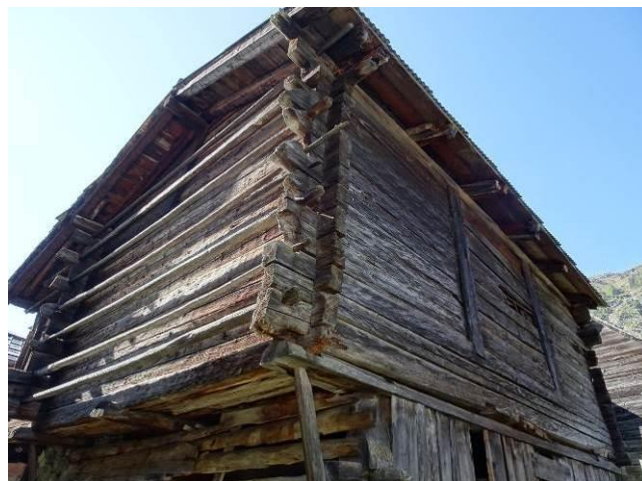
Raccard, Vallorcine, Le Mollard, ch Cascade-375_p772_ détail des assemblages à mi-bois et des perches
