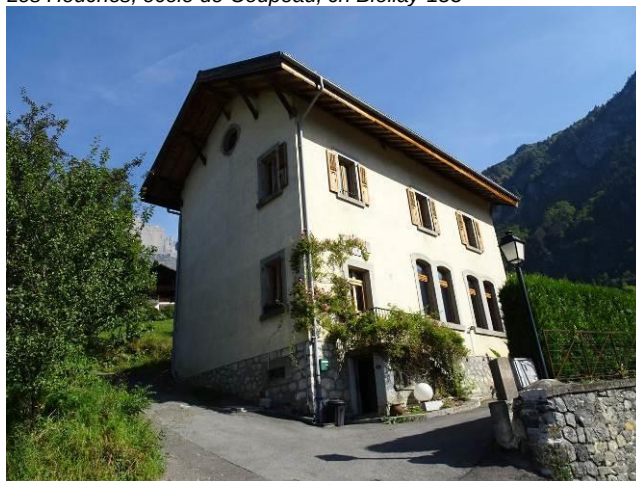
Servoz, école du Mont, ch Ancienne Ecole-60.
