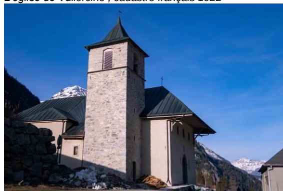
L'église de Vallorcine, extérieur restauré
