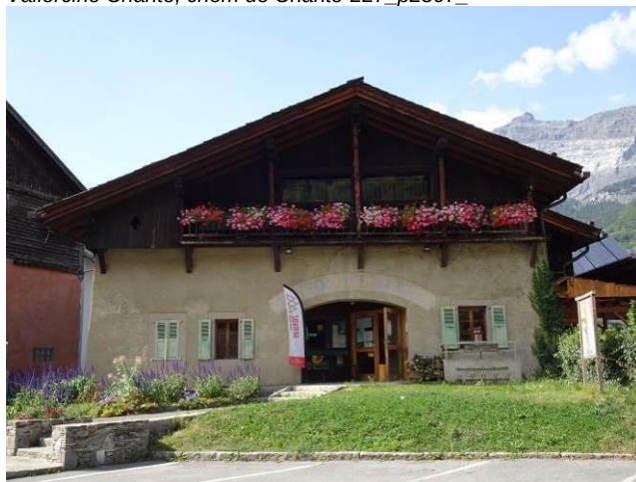
Rénovation en office du tourisme Servoz le Bouchet, r Bouchet-113_p1431
