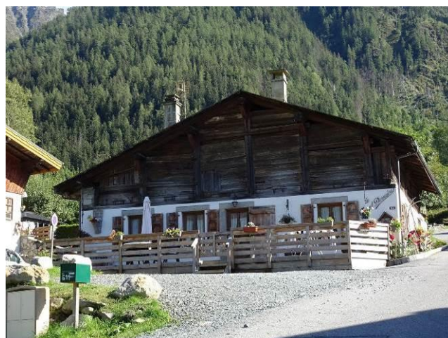
Augmentation du nombre d'ouvertures et agrandissement des ouvertures en partie basse, la grange n'est pas aménagée. Les Houches, rte Pont-623_p5252
