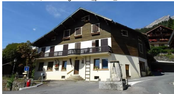
Réhabilitation années 60 (ancien hôtel). Ouvertures régulières, murs maçonnés remontés Servoz, Le Mont_rte Abergement-5_p4440
