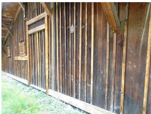
Détail d'un mantelage, les couvre-joints ont été rajoutés à postériori quand la grange est devenue habitation. Les Houches, Vaudagne_ch Ravanets-414_p4783_
