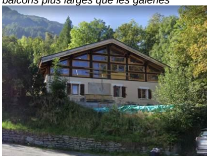
Les parties granges trop vitrées
