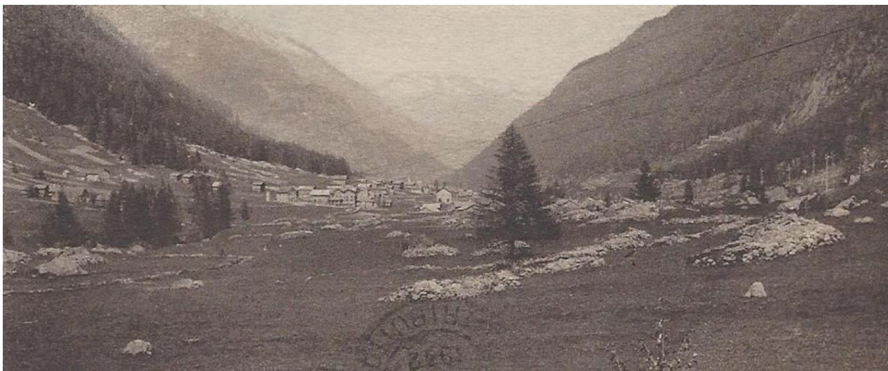
La pierre, en pierriers ou murgers, en soubassement ou en murs de soutènement et clôtures, est omniprésente dans les paysages de Vallorcine.
