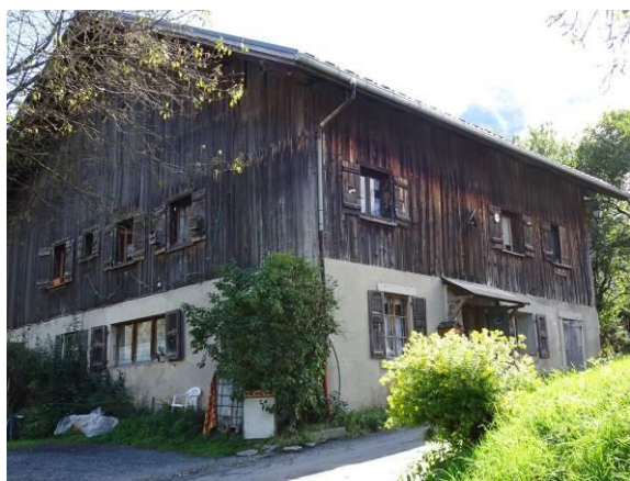
Fermeture de la grange, système mantelage. Les Houches, La Griez, rte Griez-181_p1532
