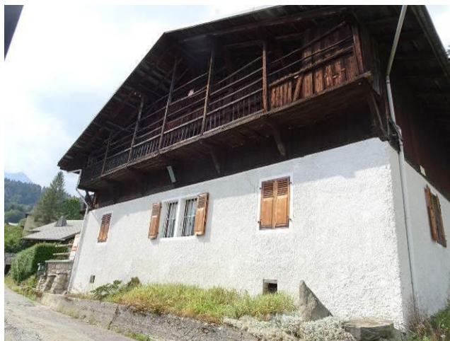
Le garde-corps est constitué d'un barreaudage très simple. Les Houches,Vaudagne_ch Ravanets-135_p1404
