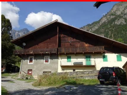
Interventions différentes sur un même bâtiment, y compris en toiture
