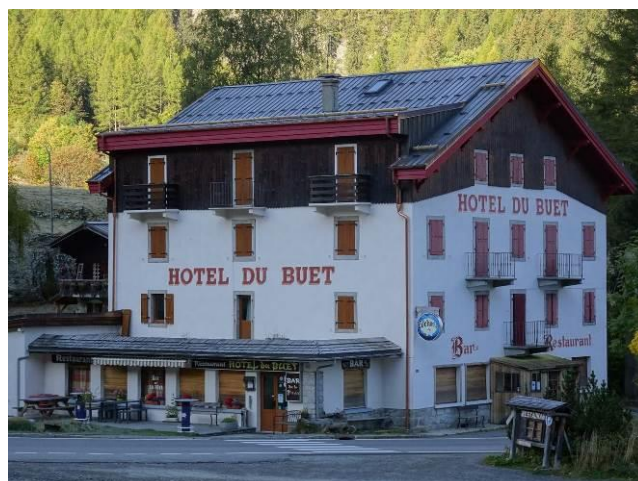
Vallorcine, Hôtel du Buet, rte Col-2026_p2683_ Extension latérale au rez-de-chaussée, surélévation générale d'un étage, puis modification de la toiture (en deux étapes) pour augmenter l'espace dans les combles.
