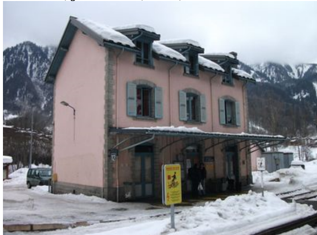
Les Houches, gare des Houches, Coupeau, rte Gare-440
