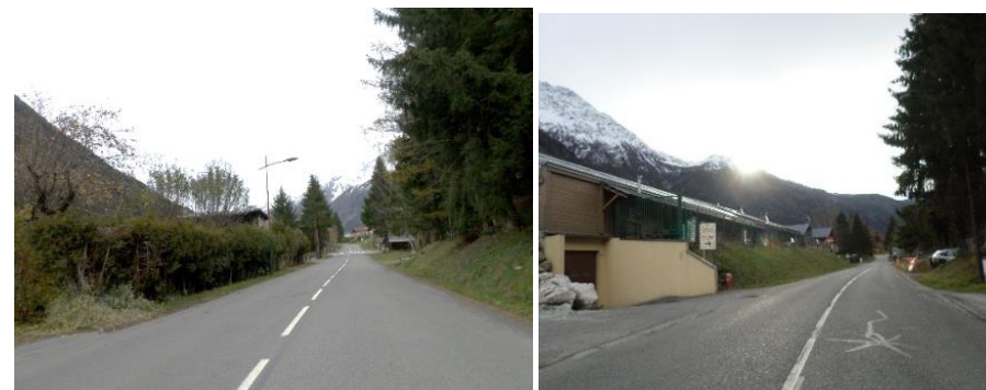
Passage fermé – Limite communales, entrée NE à aménager
